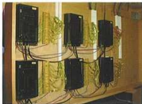
Komponenten für die 2. Bauphase. (Bild 14)
